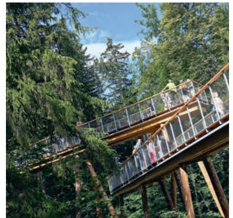
Schlaufensteg mit Blick in den Wald.
