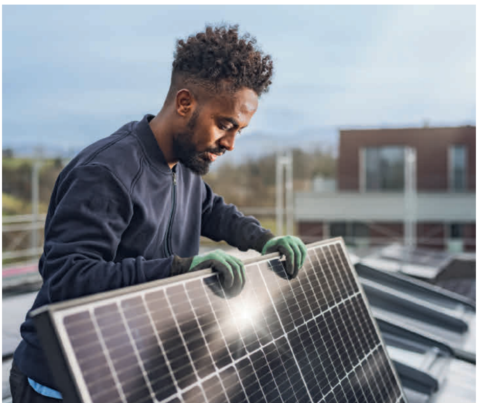
Alem Solomon bei der Montage einer Photovoltaik-Anlage.
