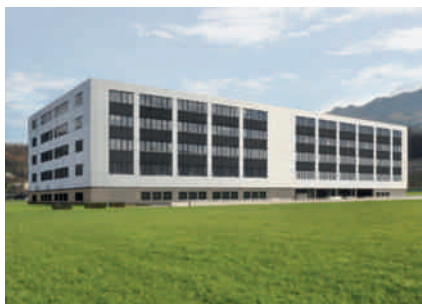
Gewerbebau Leister AG, Sarnen / 2019
