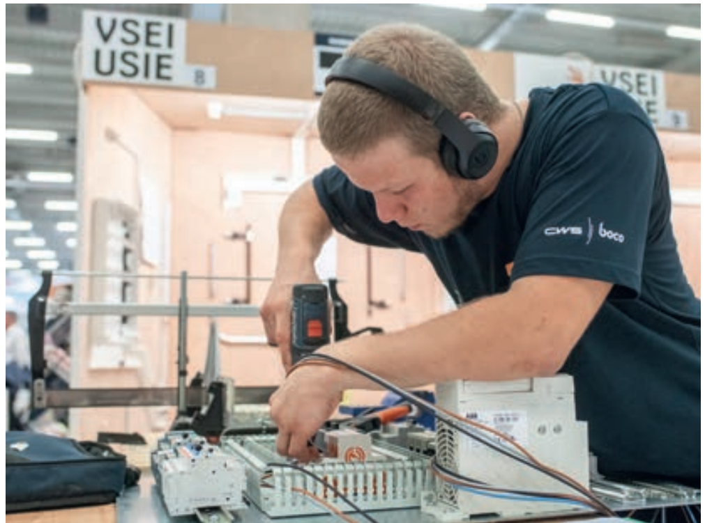
Ein Elektroinstallateur an der Arbeit.
