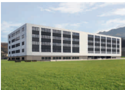
Gewerbebau Leister AG, Sarnen / 2019
