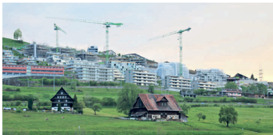
Der Ribetschi-Park ist im Bau.
