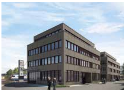
Gewerbehaus Rigiblick, Steinhausen / in Ausführung
