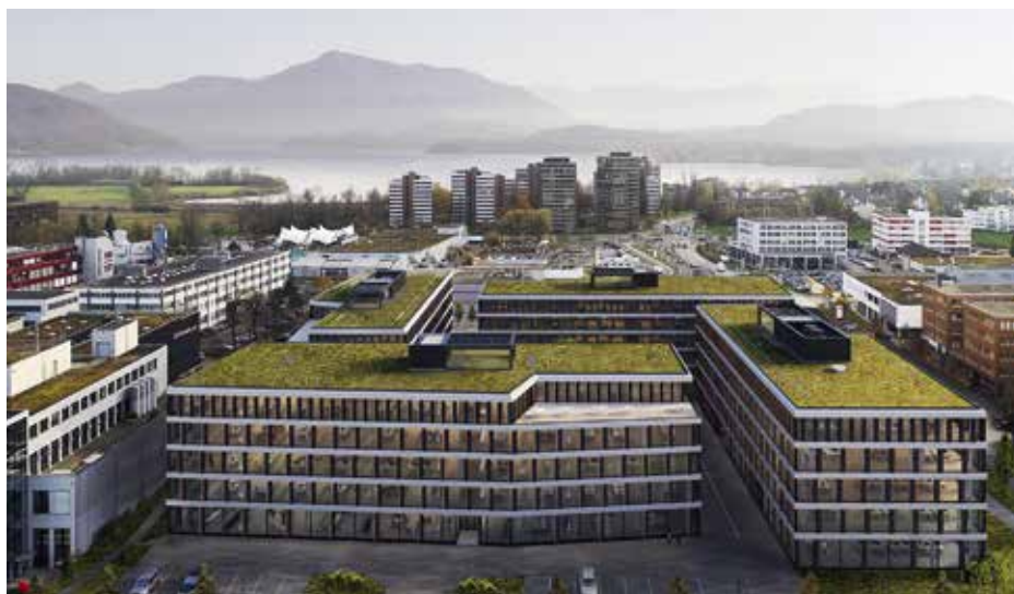
Gut erschlossen, repräsentativ und voll vermietet: Das Geschäftshaus Quadrolith in Baar ist eines von zwei grossen Bauprojekten, welches die Alfred Müller AG derzeit im Kanton Zug auf eigenes Risiko realisiert. Aufgrund des Vermarktungserfolges startet das Immobilienunternehmen im April mit der zweiten Etappe. Foto Regine Giesecke
