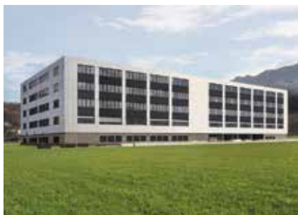
Gewerbebau Leister AG, Sarnen / in Ausführung
