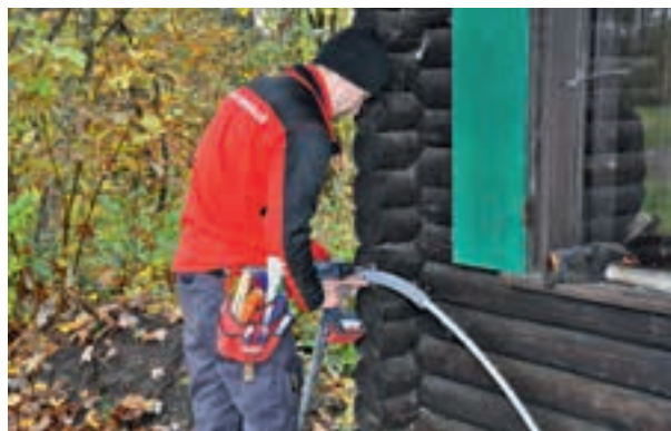
Ein Lehrling von Elektro Annen AG montiert eine neue Leitung
