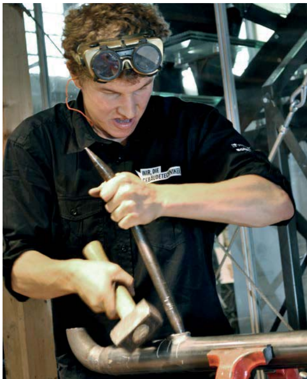
Ein Sanitärlehrling an der Arbeit
