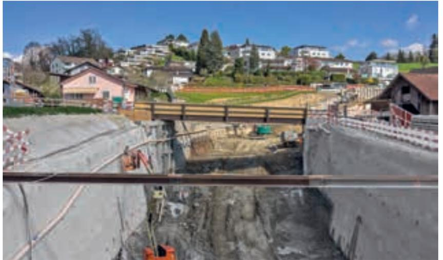
Die rund 12 Meter hohen Wände des Geissbüel-Tunnels werden betoniert
