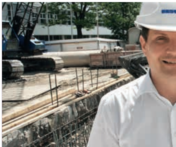
Peter Rust, Präsident des Baumeisterverbandes Zug, auf einer Baustelle
